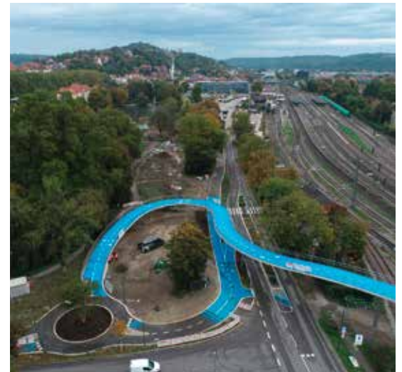
Auch im Winter ist die Brücke dank Heizung befahrbar. Bilder: Universitätsstadt Tübingen
